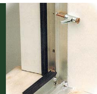
Ukřivovací šrouby zabírají vychýlení oken a dveří do bočních poloh
