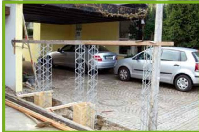
Wandsäulen ausrichten und Beton aushärten lassen.
