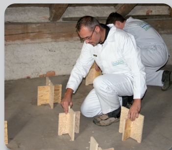
Moduly se rozmístí v rozestupech cca. 80 cm od sebe
