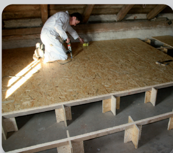
Podlahu vytvořit např. z OSB desek 18 mm s pérodřážkou
