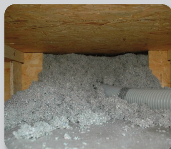
Volné prostory se vyfoukají celulóзовou izolací ISOCELL
