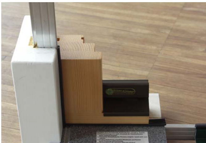
Außenansicht: Fenster im Blindstock eingebaut
