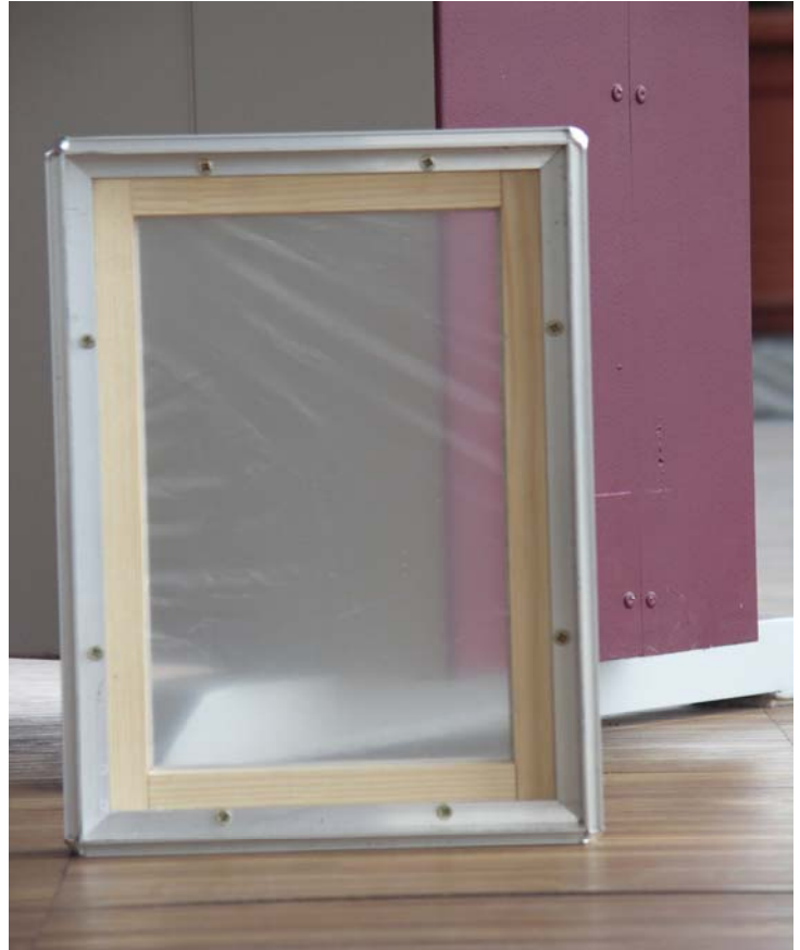
Provisorischer Folienverschluss für eine zugluftfreie Baustelle im Winter
